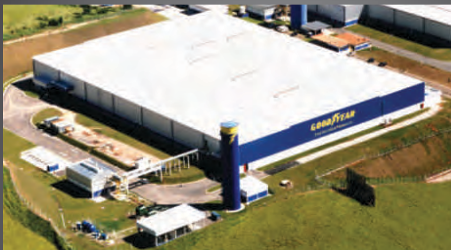
Fábrica de Correias Automotivas na Rodovia Castello Branco Santana de Parnaíba - SP
